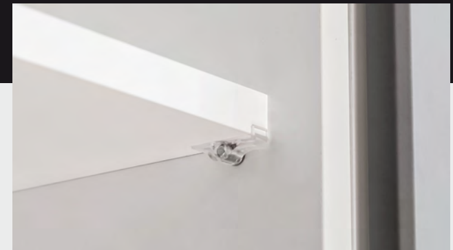
Wszystkie podpórki w szafkach wiszących posiadają zabezpieczenie przed niekontrolowanym wysunięciem półki.
