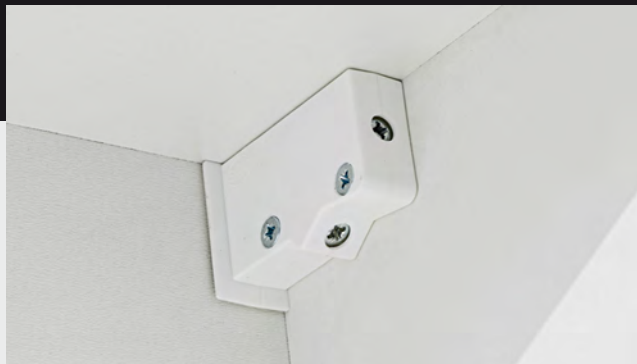
Regulowane zawieszki w szafkach wiszących umożliwiające regulację wysokości zawieszanej szafki, oraz dociąg szafki do ściany.
